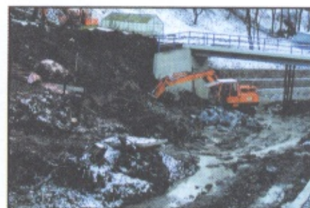
Budowa mostu do osiedla Opoka - Rusin wraz z umocnieniem koryta rzecznej
