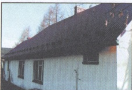
Wymienione pokrycie dachowe w Przedszkolu w Jodłowniku
