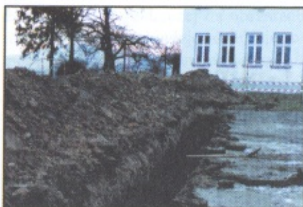
Budowa pompy ciepła w ramach termomodernizacji Szkoły Podst. w Krasnem - Lasocicach
