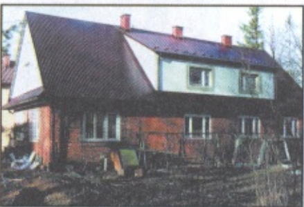
Gruntowny remont Przedszkola i Biblioteki w Szczyrzycu
